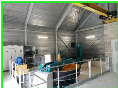
Le fonctionnement effectif de la centrale a démarré après les premières pluies d'octobre. La puissance s'ajuste au débit de la Seine grâce à un automate qui pilote en temps réel les différents équipements.
